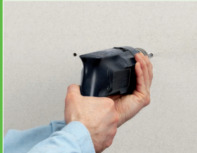
2. BOHREN (mit handelsüblichem Ø 6 mm Bohrer)
