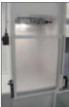
Labor-/Analyseschrank mit Absaugung und Beleuchtung
