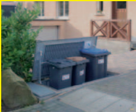
Tiefgarage für Abfallbehälter
