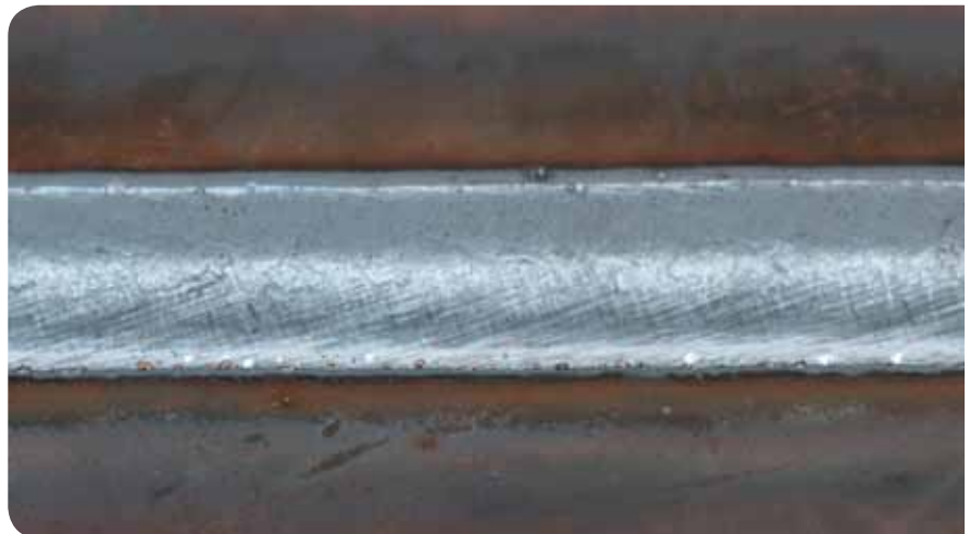
Schweißnaht – z.B. Speed Weld Prozess
